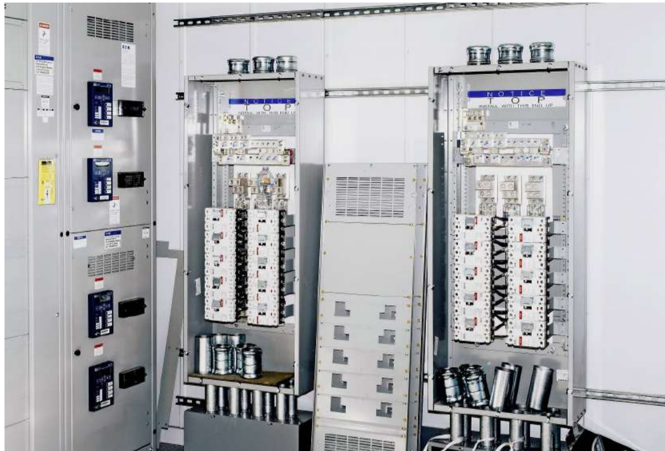
Die Batterieanlage der San Diego Gas & Electric in Escondido. Foto: Coley Brown («New York Times», Redux, Laif)
